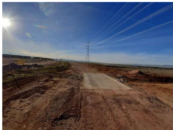
Imagen 1 y 2 Vago hormigonado en vial público
