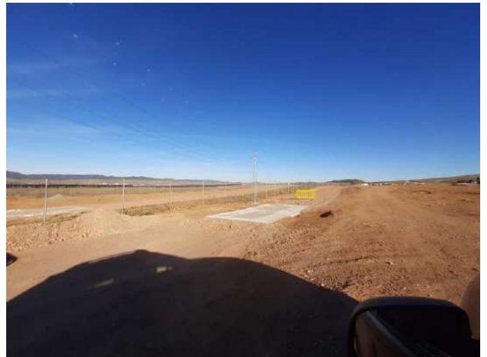
Imagen 1 y 2 Vados hormigonados en parcelas 2 y 3 para favorecer el paso de agua y evitar su deterioro
