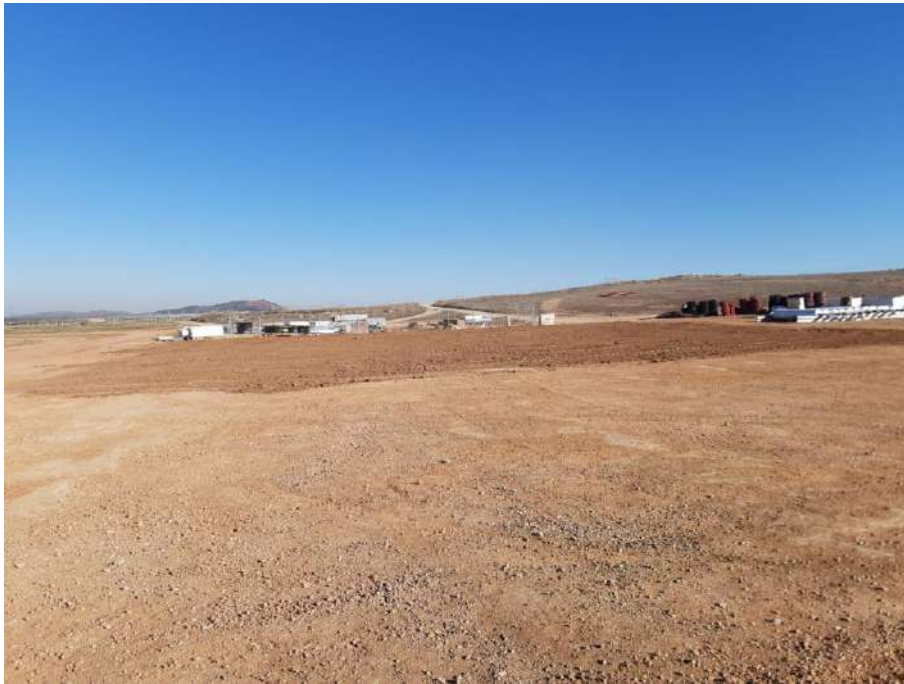
Imagen 1. Inicio de trabajos de restauración en zona auxiliar de obra.
